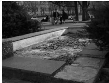
Die Wasserbecken sind ungenützt und verfallen
